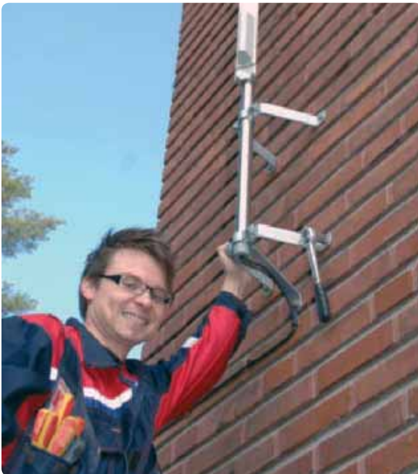
Ville Pirhonen Mitox Oy:stä tekee etäuenta-asennuksia Pakilan-Paloheinän alueella.
