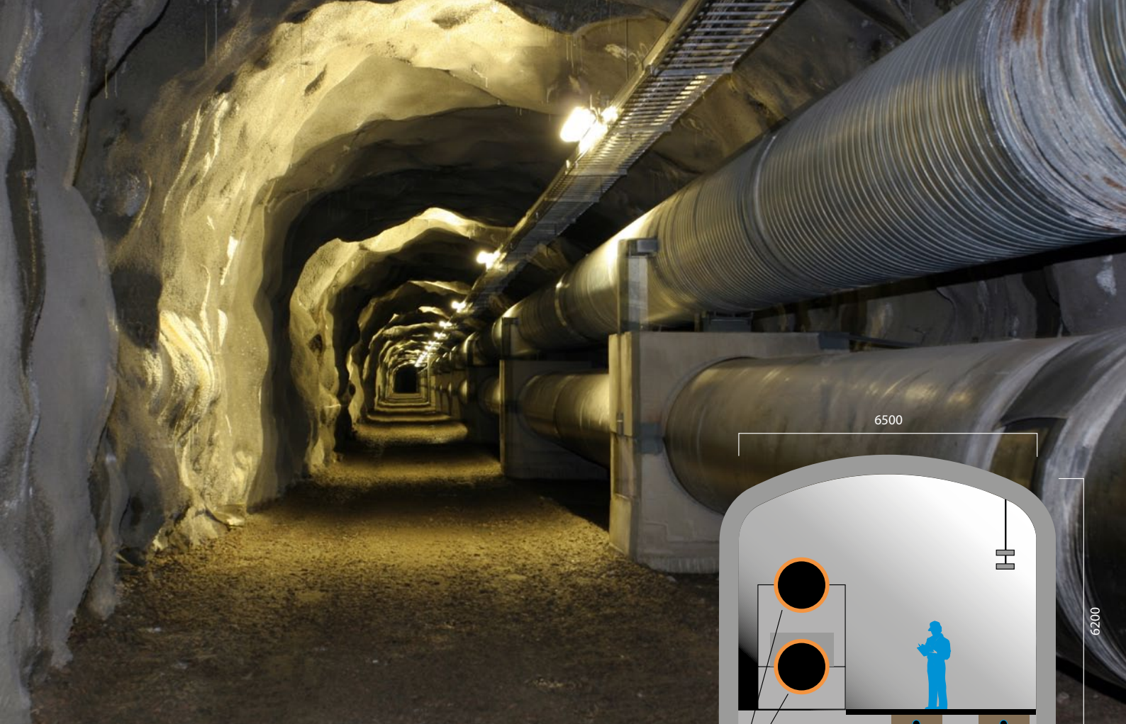
Esimerkkikuva Helsingin Energian yhteiskäyttötunnelista ↗ Energiatunnelin poikkileikkaus »
