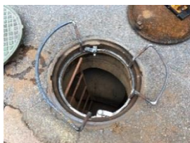
Kuva 1. Kaivoon pikakiinnityksellä asennettava putoamisenestokehikko
